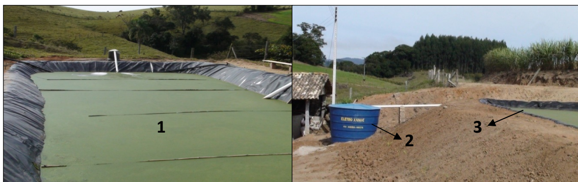
Figura 01: 1- lagoa de lemnas utilizada no tratamento; 2- Reservatório para reuso do efluente tratado; 3- segunda lagoa de lemnas para o polimento do efluente.
